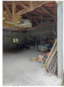
Grand espace existant : dalle béton non isolée, murs en parpaings, charpente bois et couverture tuiles
