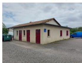
Accès sanitaires publics et façade arrière
