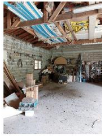
Grand espace existant : dalle béton non isolée, murs en parpaings, charpente bois et couverture tuiles
