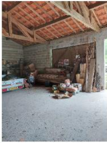
Grand espace existant : dalle béton non isolée, murs en parpaings, charpente bois et couverture tuiles
