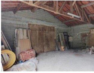
Grand espace existant : dalle béton non isolée, murs en parpaings, charpente bois et couverture tuiles
